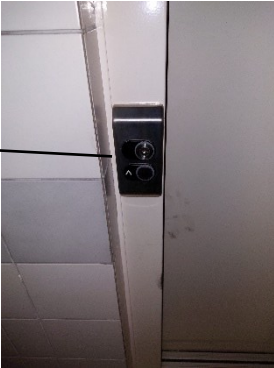
Porte donnant sur couloir avec bouton extérieur d'appel nécessitant une clé à chaque étage
