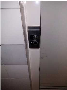
Porte donnant sur couloir avec bouton extérieur d'appel nécessitant une clé à chaque étage sauf le -1
