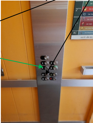
Ouverture de la porte côté couloir avec clé
